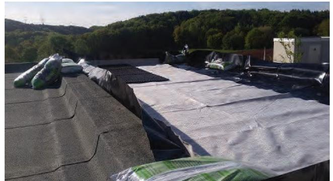
Bei der Dachbegrünung müssen verschiedene Schichten von Folien aufgebracht werden, bevor die Substratschicht als letzte Schicht kommt
